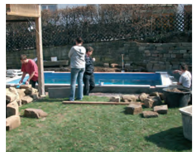
Mit einem LKW wurde das Fertigbecken angeliefert und per Kran in die vorbereitete Baugrube gesetzt. Anschließend konnte das Becken angeschlossen, verrohrt und hinterfüllt werden. Binnen weniger Tage war das Schwimmbecken badefertig und konnte den Bauherrn übergeben werden.
