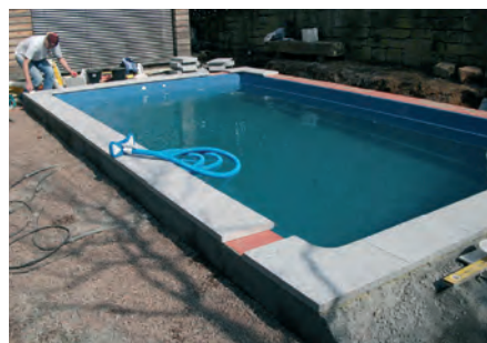
Mit einem LKW wurde das Fertigbecken angeliefert und per Kran in die vorbereitete Baugrube gesetzt. Anschließend konnte das Becken angeschlossen, verrohrt und hinterfüllt werden. Binnen weniger Tage war das Schwimmbecken badefertig und konnte den Bauherrn übergeben werden.
