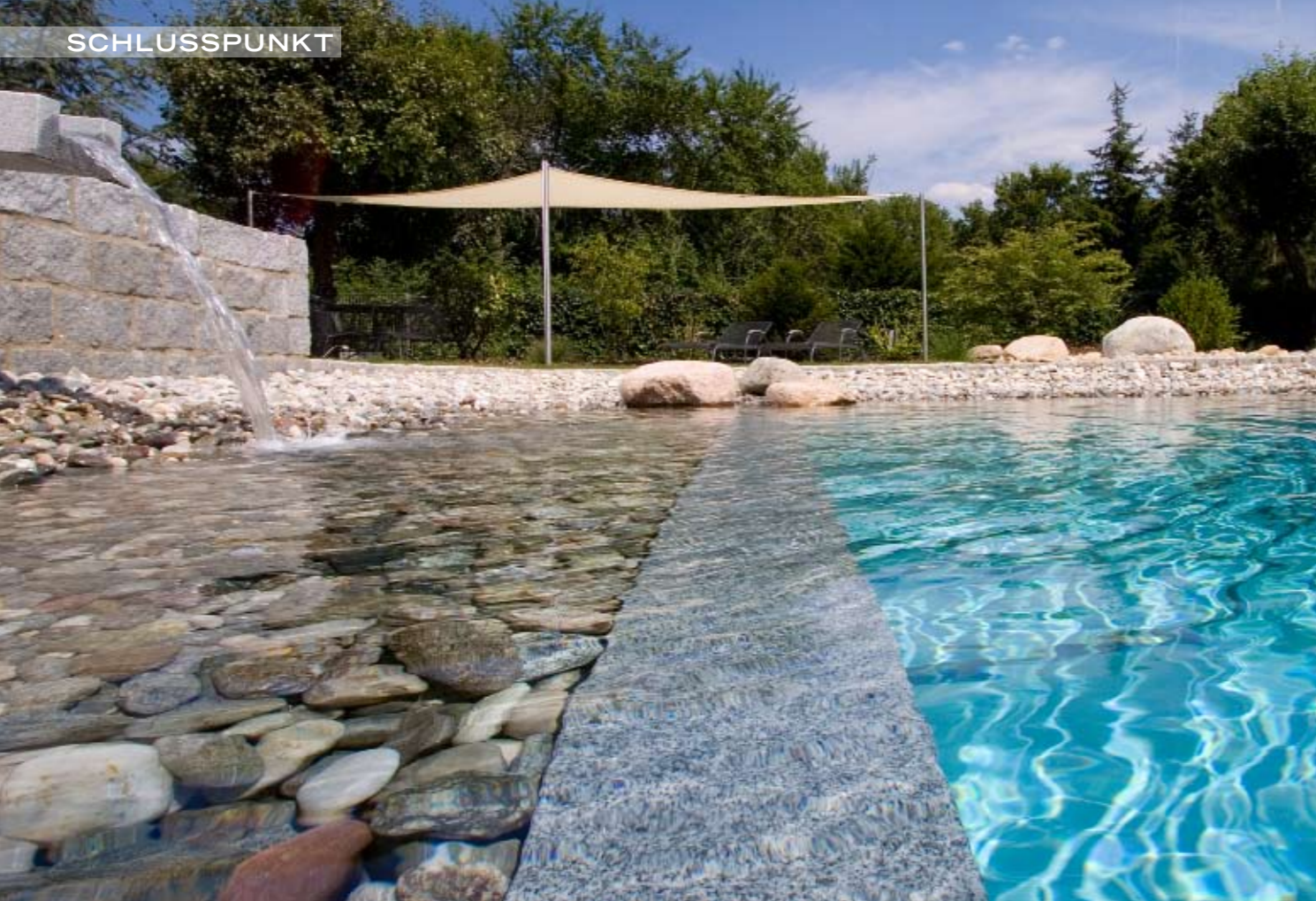
Der unter der Wasserlinie liegende Beckenkopf ist mit grauem Naturstein abgedeckt – passend zu den überwiegend grauen Flusskieseln im Strandbereich um den Pool.
