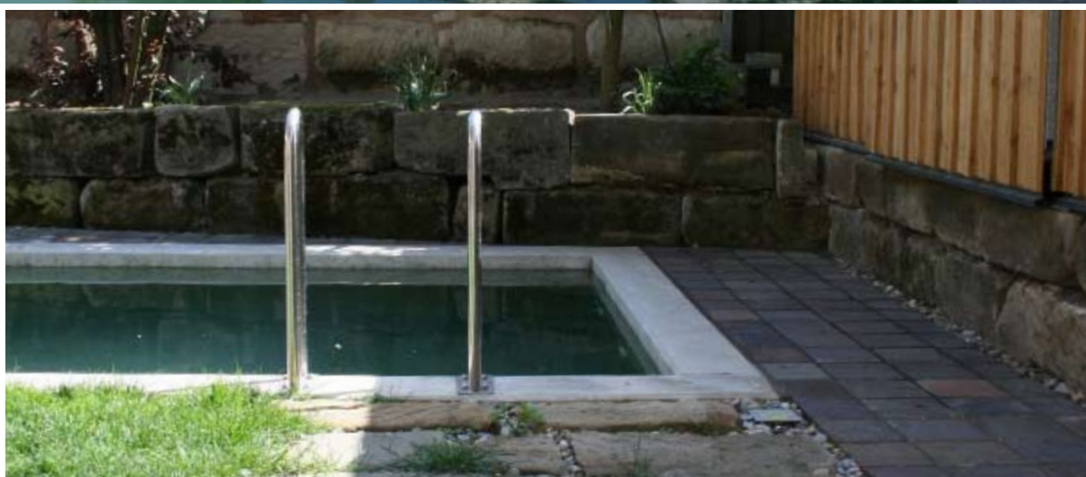
Die Edelstahlleiter mit vier Stufen und Handlauf ermöglicht einen ebenso bequemen wie sicheren Zugang in das Becken ( www.eichenwald.de ).
