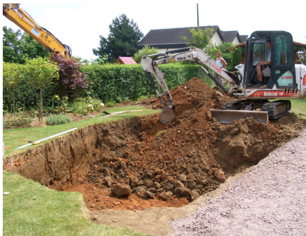
Allzu große Beschädigungen im Garten konnten vermieden werden. Der Aushub erfolgte präzise, und der Fertigpool wurde in die vorbereitete Grube gesetzt.
